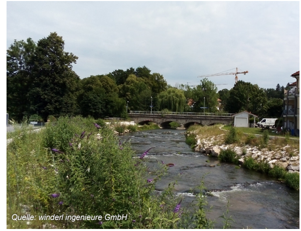
Quelle: winderl ingenieure GmbH Verbesserte Gewässerstruktur
